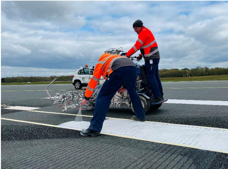
Abbildung 1: Neue Bezeichner für Runways werden aufgetragen (Quelle Köln-Bonn Airport)
